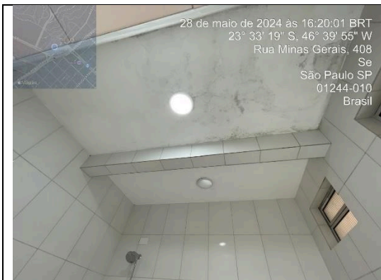
Foto 80 – Vista 2 / Banheiro P.N.E. (Térreo)
