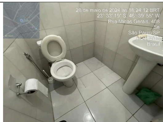
Foto 93 – Vista 2 / Banheiro fundos
