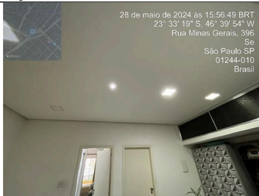
Foto 24- Vista 4 / Pav. superior
