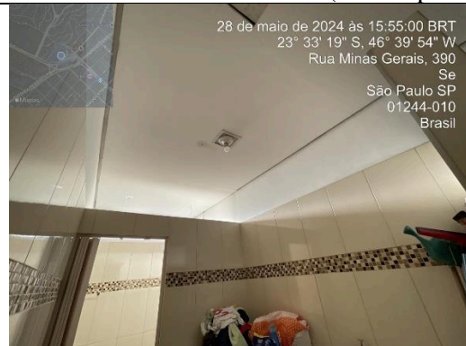
Foto 44- Vista 3 / Lavanderia (Pav. Superior)
