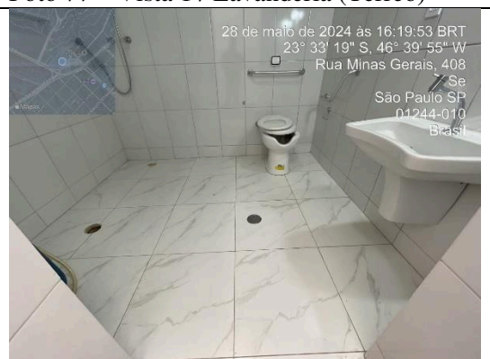
Foto 79 – Vista 1 / Banheiro P.N.E. (Térreo)
