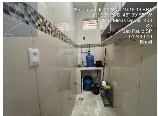
Foto 77 – Vista 1 / Lavanderia (Térreo)
