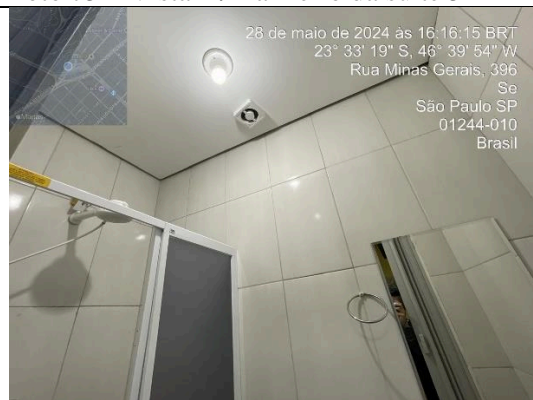
Foto 76 – Vista 3 / Banheiro da suíte 5
