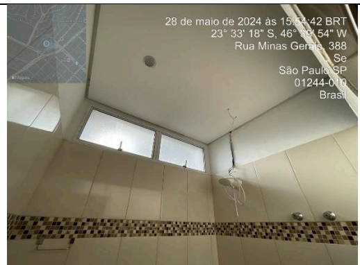
Foto 46 - Vista 2 / Banheiro (Pav. Superior)
