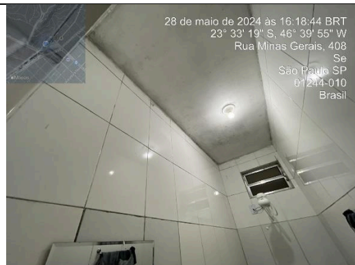
Foto 67 – Vista 3 / Banheiro da suíte 2
