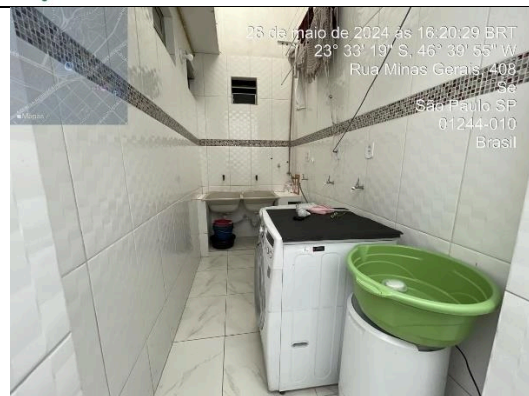
Foto 81 – Vista 1 / Lavanderia 2 (Térreo)
