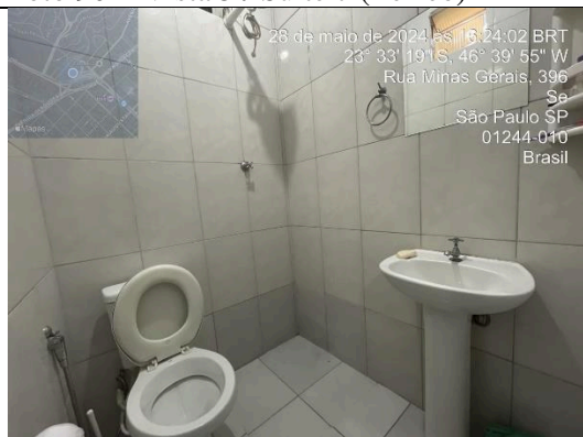
Foto 92 – Vista 1 / Banheiro fundos
